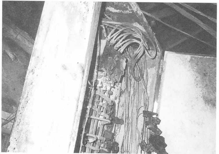
▲각종 개폐기나 차단기는 부하 용량에 적합한 것으로 시설해야하며, 파손되었거나 손상된 것은 즉시 교체하여야 한다.
