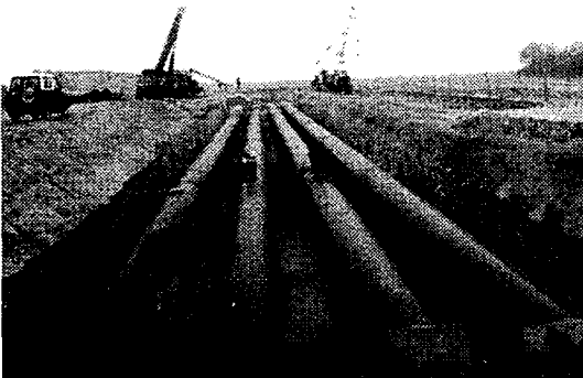
Fig. 4. 지하 매립 배관 건설 현장이 주배관망은
