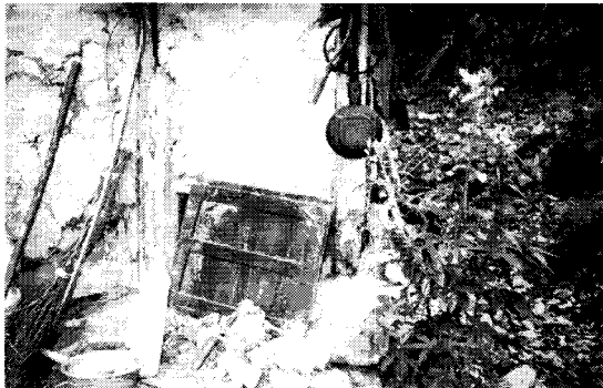
<사진 12> 마루밑 공간 뒷 쪽에 부착된 소형 출입문
