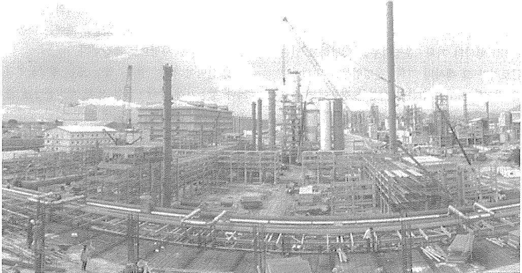
삼성엔지니어링 태국 TPI 플랜트 건설 현장
