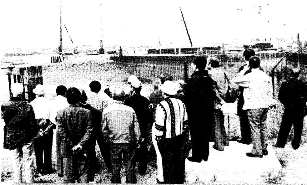
◀ Cardiff 히구독 공사지구 견학
