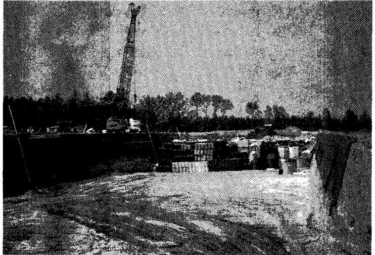
미국의 Barnwell 처분 시설. 미국 전역에서 발생하는 저준위 폐기물을 처분하고 있는 유일한 시설로, 처분 방식은 트렌치를 파서 포장된 폐기물을 묻고 복토를 하는 매우 단순한 방식을 사용하고 있다.
