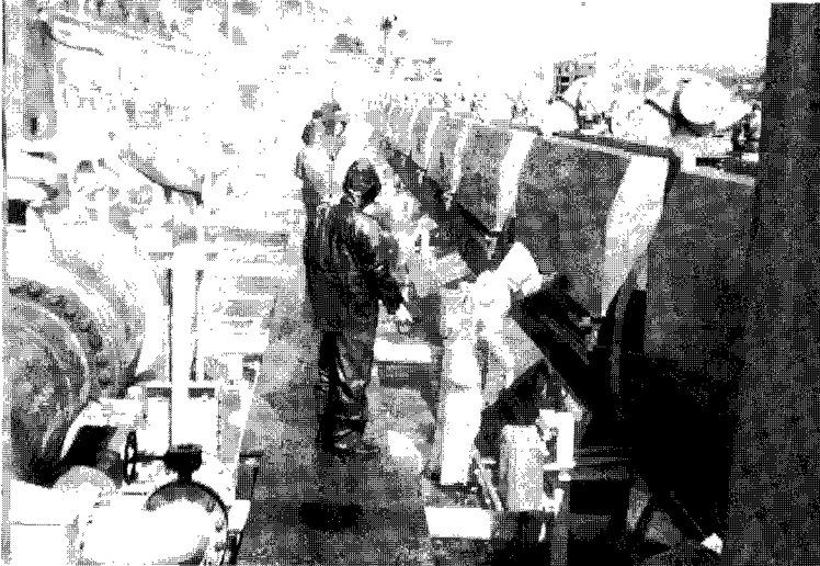
취수구에 유입되어 회전여과망에 붙은 큰 가시고기 제거 작업. OCTF의 첫걸음은 발전소의 모든 구성원들이 품질 마인드를 가지는 것이다.
