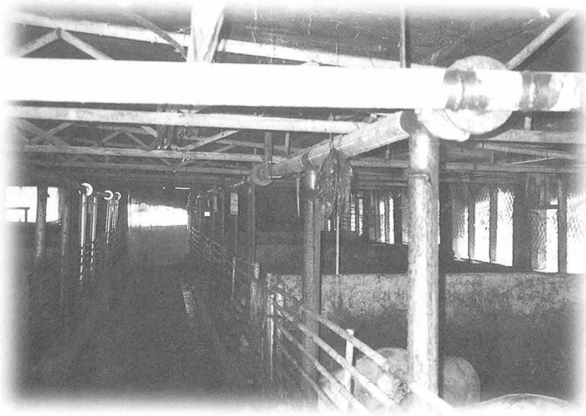
▲비육돈사 내부모습, 에어펌프를 이용해 80mm 파이프라인을 통하여 각 돈방 급여통까지 이동 되어진다.
