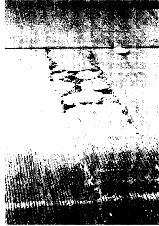
그림 7 연속철근콘크리트 포장의 펀치-아웃
