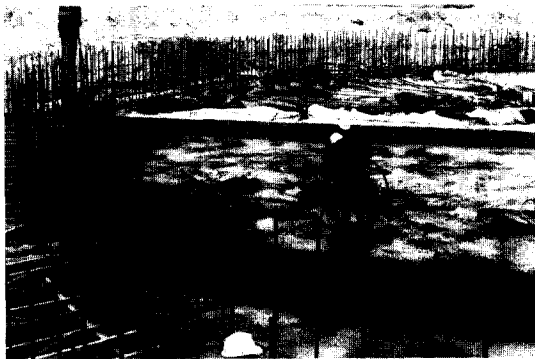
사진 1 원자력구조물의 subbase 부분 콘크리트 타설장면
