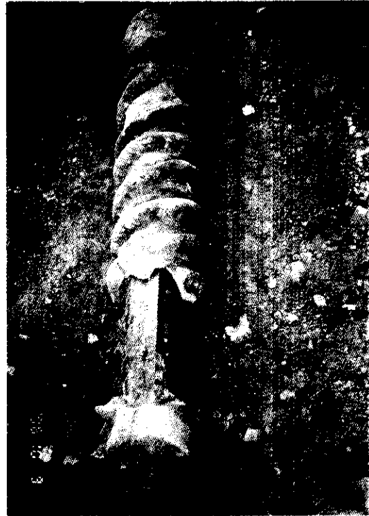
사진 4 나선돌기형 매입말뚝의 시공단면 형상
