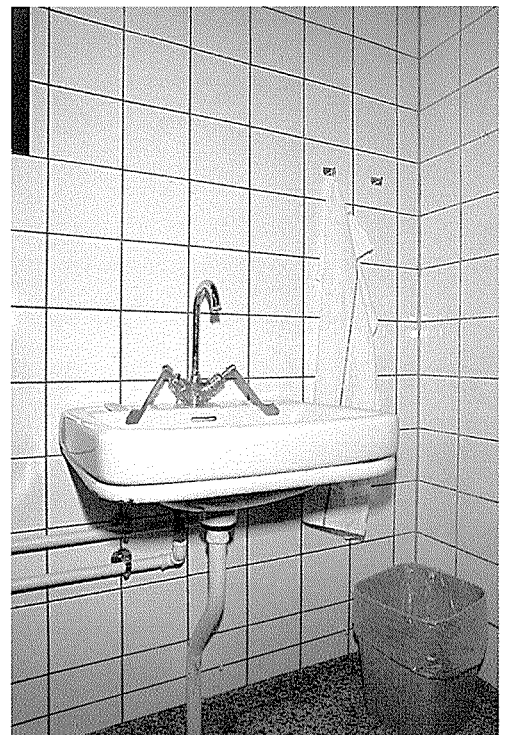
[사진1] 세면기 하부가 비어있는 세면기는 휠체어 사용자의 접근성을 좋게 해준다
