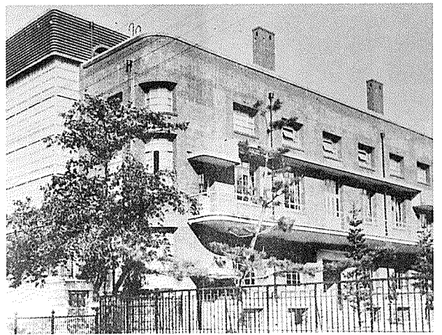
전라남도 평의회의장(1932. 김순하 설계) 한국인 건축가가 활동하던 1930년대는 합리주의, 기능주의, 모더니즘 건축이 주류를 이루고 있었다.
