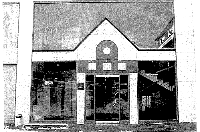
1층 계단실 출입구
