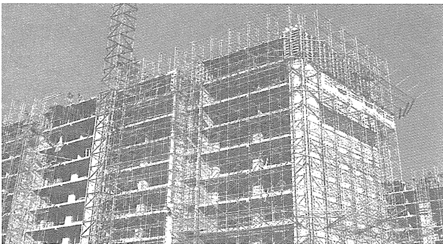
APT 건설현장에 설치된 강관 비계
