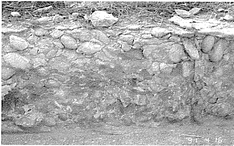
사진 2. 동해에 의한 콘크리트경계석의 손상예
