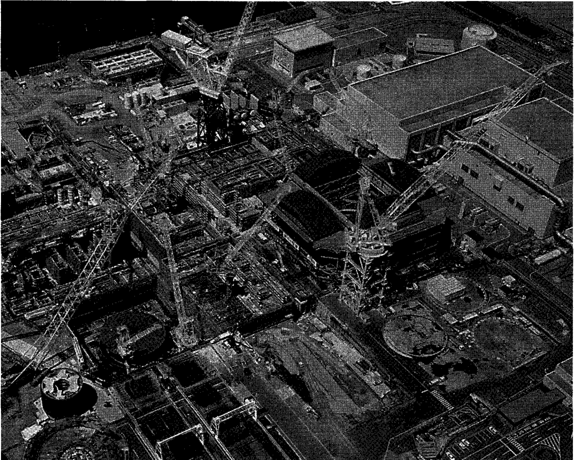
가시와자키 가리와 6·7호기 건설 모습
