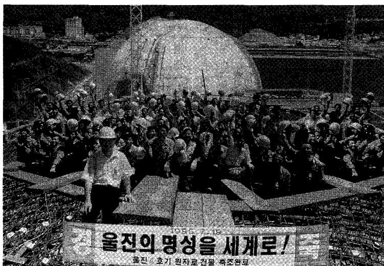
울진 원전 건설 종사자들이 울진 4호기 원자로 건물 돔에 올라가 울진 4호기 원자로 건설 속도 완료를 축하하는 환호를 터트리고 있다.
