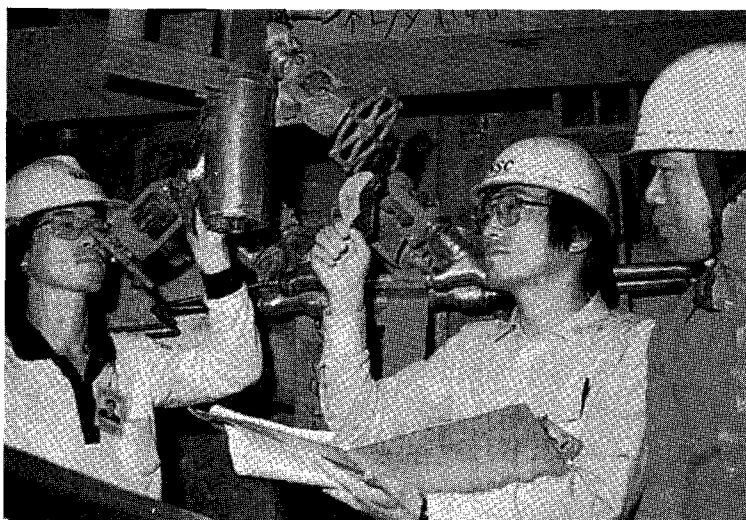
원전 가동전 검사 장면. 우리 원자력산업의 고도성장의 배경에는 원자력 안전과 관련된 각종 체제 및 제도의 지속적인 보완과 준수가 항상 전제되어 왔다.
