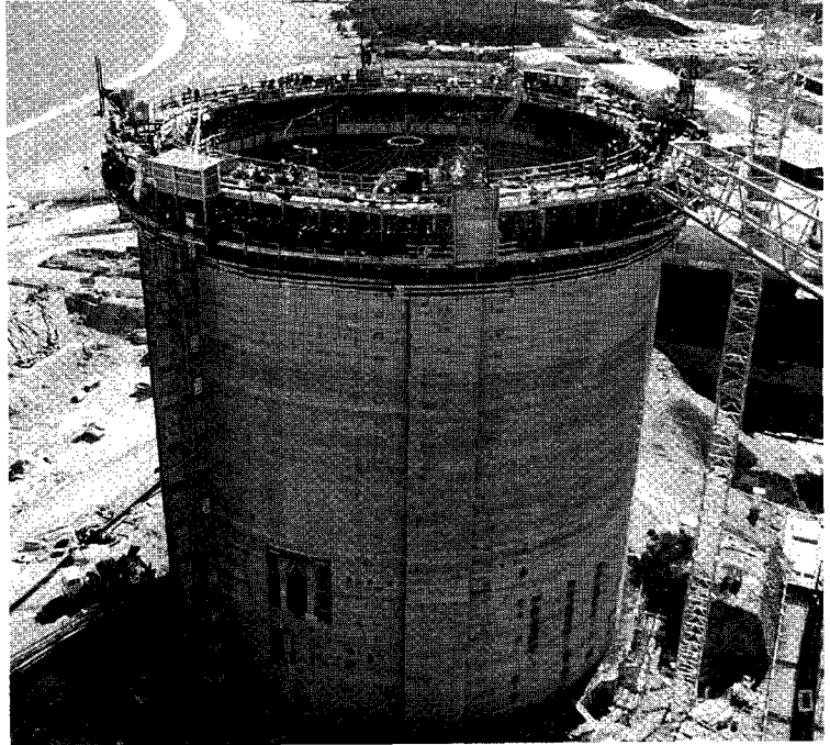
슬립폼 공법에 의한 원자로건물 외벽 축조공사의 완료된 모습(월성원자력 4호기)
