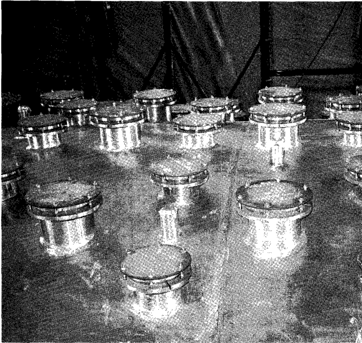
칼린드리아 노즐 커버 설치
