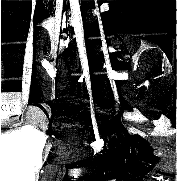
원자로냉각재 펌프 정비작업 장면. 한전기공(주)은 신뢰와 안정속에서 도약하는 기술로 정비기술의 선진화를 추진할 것이다.
