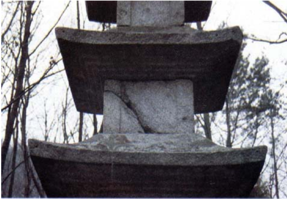
사진 11. 線理에 의한 손상(金山寺 沈源庵三層石塔)
