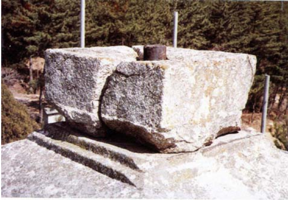
사진 1. 찰주 및 노반의 전단파손(羅原里五層石塔)
