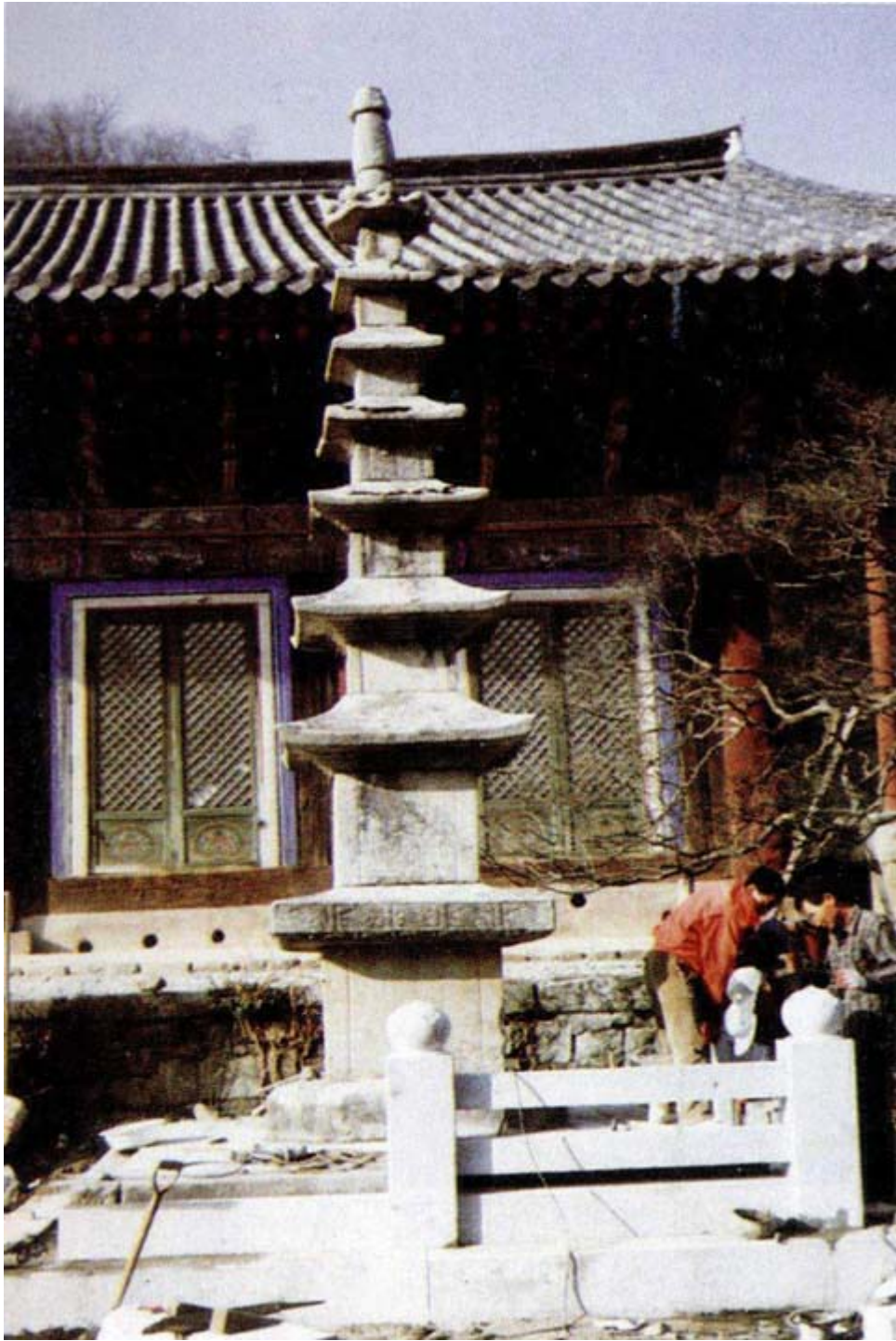
사진 3. 상륜이 기울고 옥개석은 균열(고창 선운사칠층석탑)
