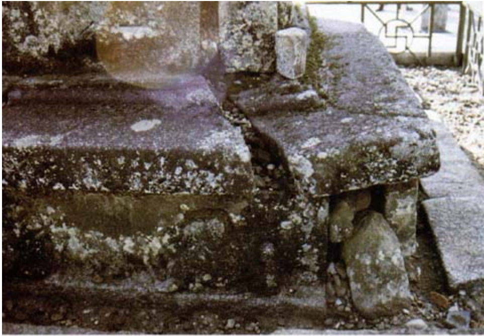
사진 13. 기단부의 弛緩 顛倒現況(華嚴寺 西五層石塔) 이화 석탑 華嚴寺 西五層石塔
