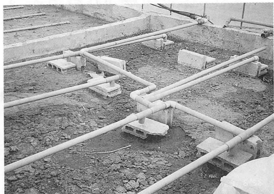
▲ 자동모터펌프에 의해 폐수가 톱밥으로 되어있는 1단 조로 들어와 분사 되어 진다. 벽돌을 올려놓은 것은 폐수가 톱밥에 직접 뿌려져 패이는 일이 없도록 하기 위한 것이다.
