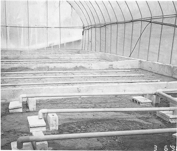
▲ 톱밥토양여과상의 내부의 모습. 총 4단조로 구성되어 있으며, 2단에서 4 단조까지의 토양위에는 옥수수등 사료작물을 재배하여 폐수중의 N, P, K 성분을 감소시켜 준다.
