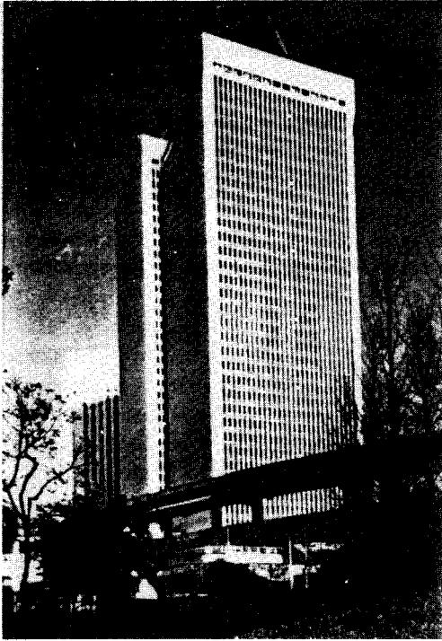
그림 7. CFRC curtain wall of the Ark Hills Mori building in Akasaka, Japan.
