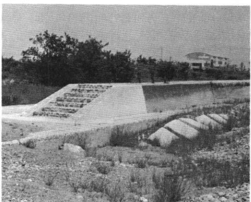
사진 10. 댐둑마루 부분에 계단 설치
