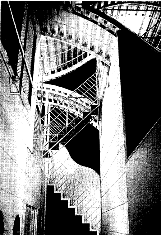
〈사진2〉 네리마 주택, 1986, 이즈코 하세가와, 내부계단.
