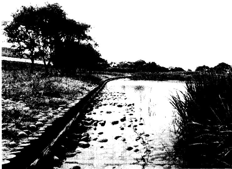
사진 2. 수제에 의한 Shallow Bay(저수로 변 작은 인공 만)의 조성(長良川) 7)
