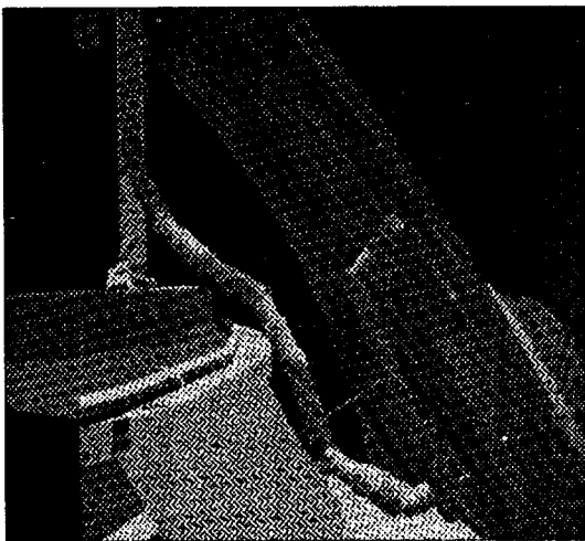
그림 7. Schilling arm을 이용한 원전 노즐담 보수작업.
