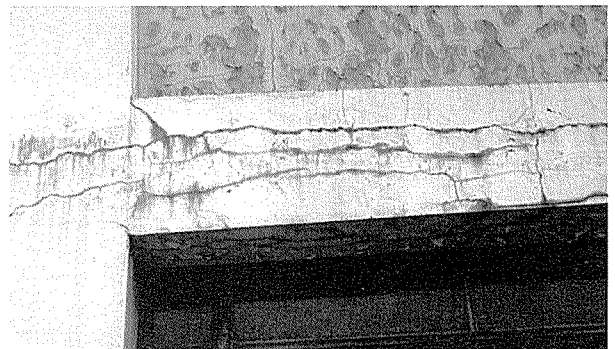
사진 3 알칼리-골재 반응에 의한 아파트 구조물의 피해(일본의 예)
