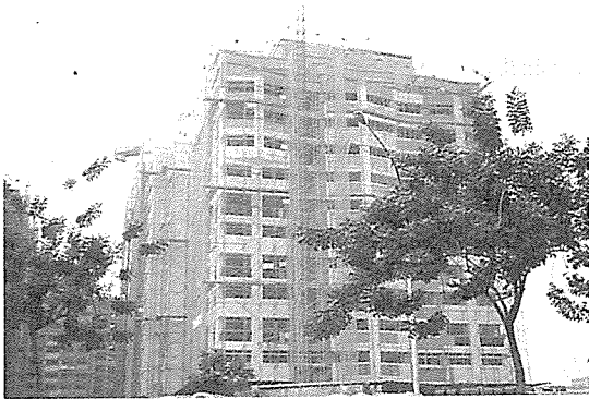
비계 설치 상태 (2중 비계)
