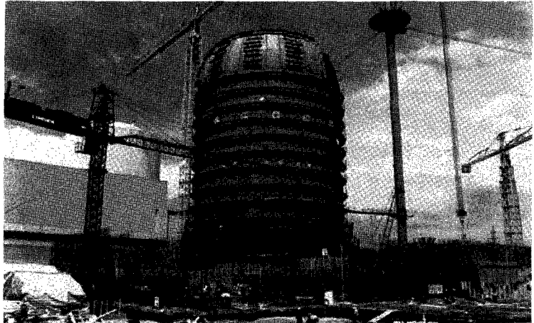
고리2호기 건설 장면
