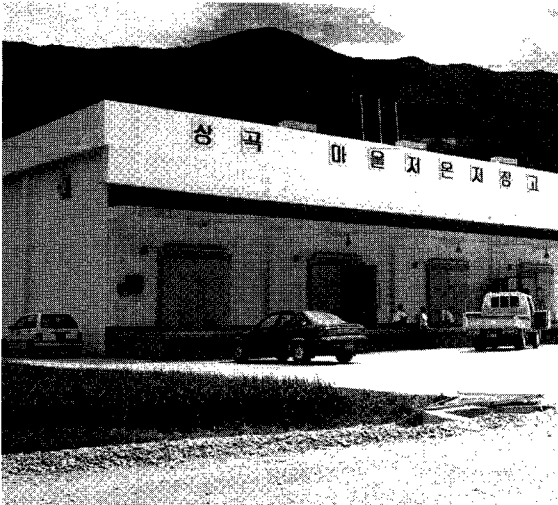
농산물 저온저장고(무주양수발전소 : 전북 무주군 적상면)
