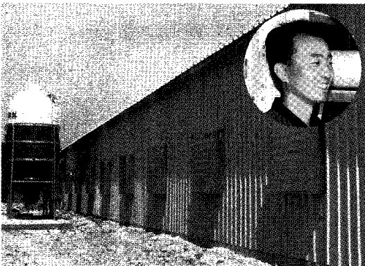
▲ 직립식 케이지가 설치된 무창계사 (원내는 백승진 대표)
