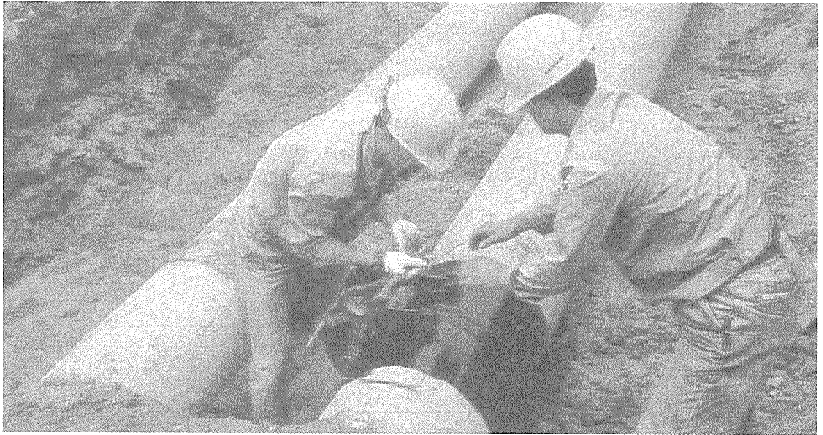
남북구간 관로매설공사 장면
