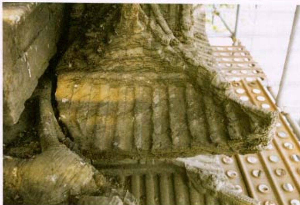
Photo 2. 석탑오염물에 대한 물리적 세척방법의 처리후 상태 (수채화붓으로 석탑표면에 쌓여 있는 배설물 등 오염물을 제거한 상태)
