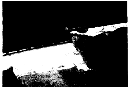
사진 3 마대와 비닐을 이용한 총양생
