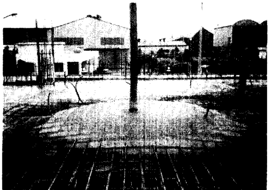
(b) 슬래브 타설 전경
