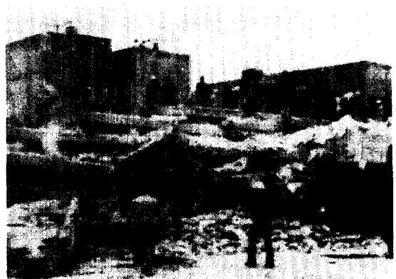
그림 12 P- \delta 효과에 의한 건물의 붕괴
