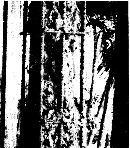
그림 11 약하게 횡보강된 기둥의 손상. (이 Tie는 90°구부렸으며, 지진후 중앙부근의 없어진 Tie를 바닥에서 발견하였음)
