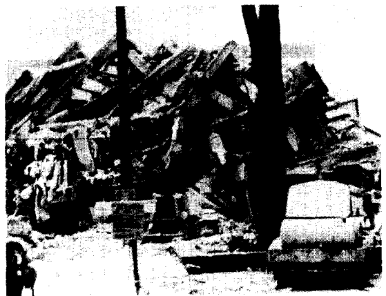
그림 9 1985년 멕시코지진에서 접합부 파괴에 의한 건물의 붕괴
