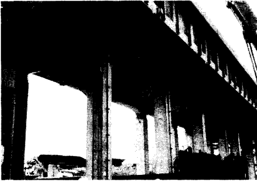
사진 6 라아멘 고가교의 기둥상판의 Haunch 아래의 파괴된 모습
