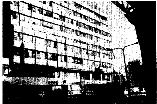
사진 2 고베시 Sannomiya 지역의 9층 건물의 5층 부분이 크게 파괴된 모습
