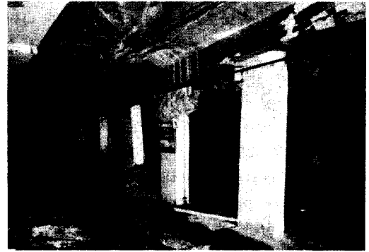
사진 7 지하철의 box라멘구조의 중간기둥과 상면슬래브의 파괴모습
