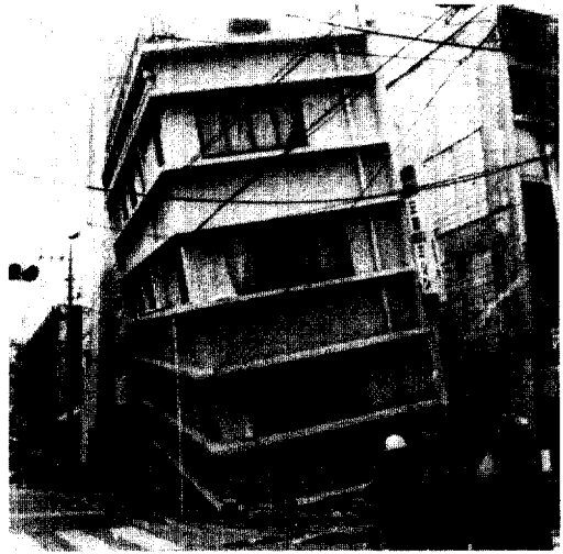
사진 1 고베시 Nagata지역의 피로티형식의 구조물 파괴양상
