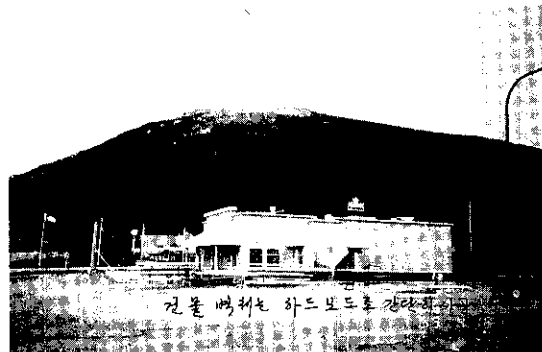
사진 1. 나무로 지은집(건물 벽체는 하드보드로 간단히 시공)
