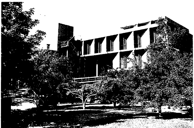
(사진12) Carpenter Visual Art Center의 파사드 brise-Soleils를 설치하였다.
