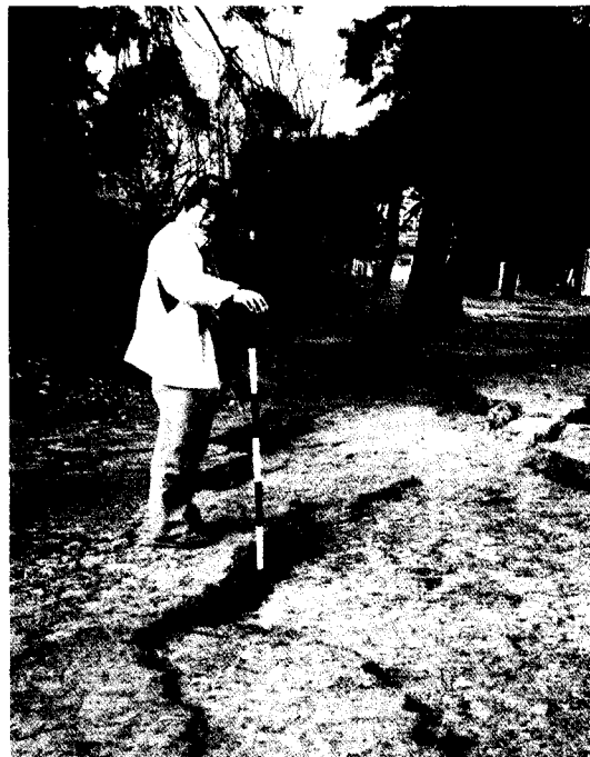
사진 7. 武庫川 고수부의 균열
