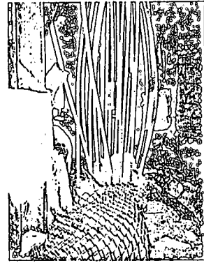
그림3. 시험발파후 내부철근이 노출된 모습
