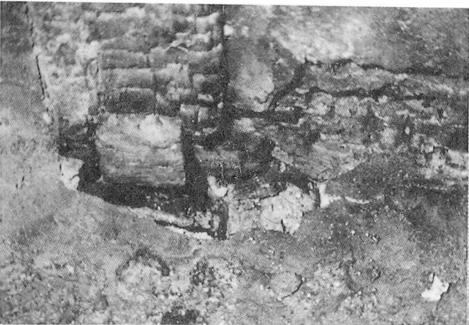
〈사진3〉 또 다른 현장의 하방목(훈소)상태
