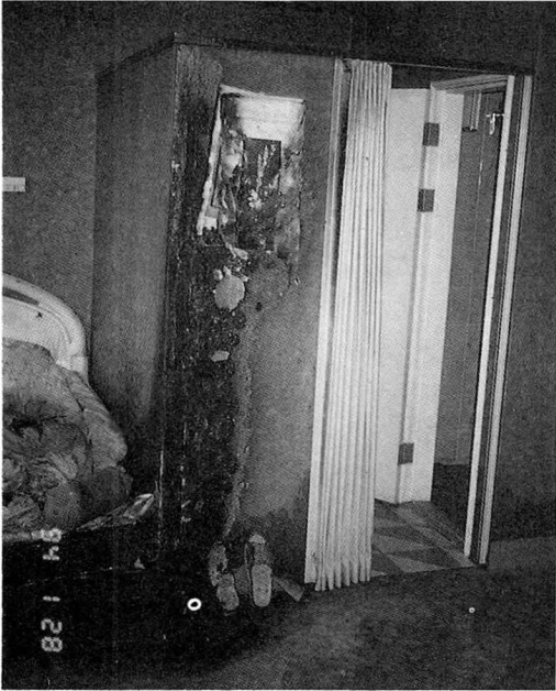
〈사진〉 달력에 인화된 불로 인하여 천정의 스프링클러 헤드가 작동, 소화되었다. (15평의 실내에는 6개의 헤드가 설치되어 있었으나 그중 1개가 작동되었다.)
