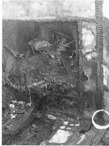
〈사진2〉 A약국 상담실 저면부 회벽의 지주목과 하방목이 훈소(○표 부분)
