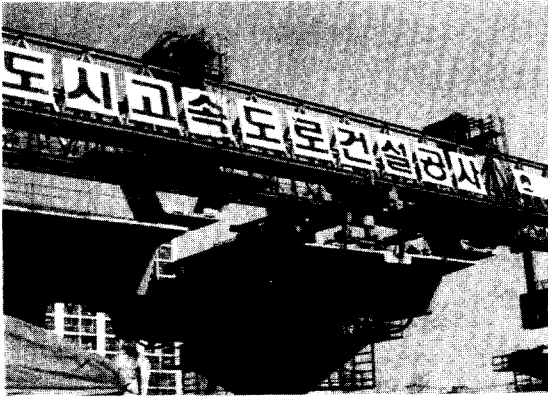
사진 8 세그먼트 가설 전경
