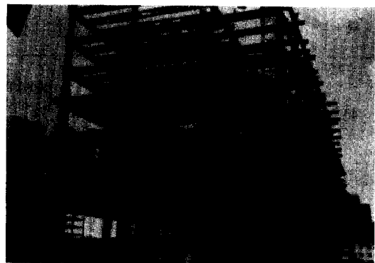
Photo.1 TMCP강으로 건축중인 POSCO경영정보센터 빌딩
