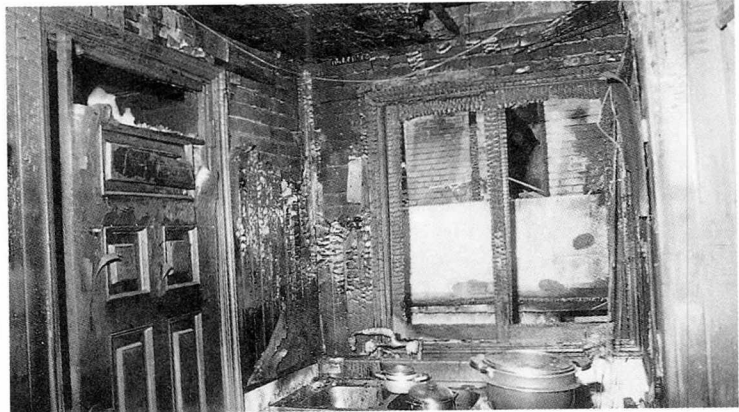
〈사진1〉 목재류의 탄화심도와 역삼각형적 연소상황은 화염의 진행이 창의측으로부터 내측으로 진행되었음을 알 수 있다.
