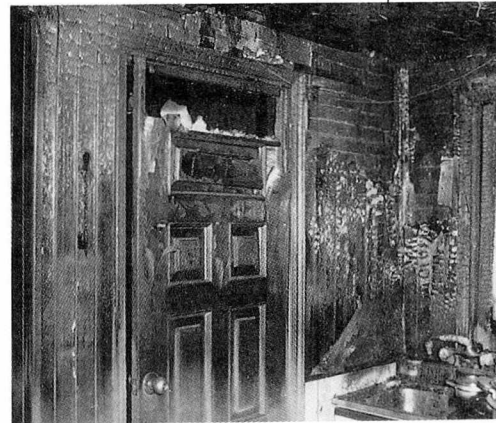
〈사진2〉 사진1의 출입구 쪽으로서 아래쪽과 위쪽의 연소진행 방향이 쉽게 식별되고 있다.
